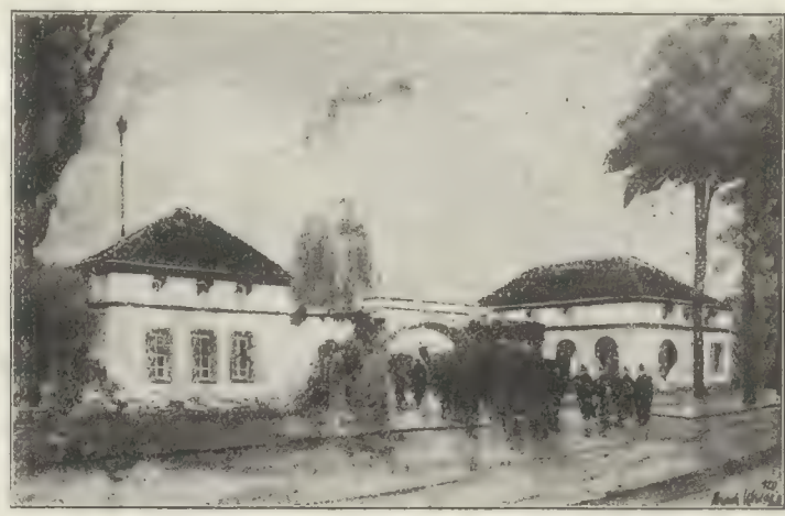
Eingangsgebäude an der Einfahrt vom Westfalendamm her.
